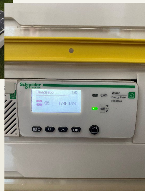
Compteur d'énergie WISER
