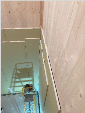
Doublage cage ascenseur
