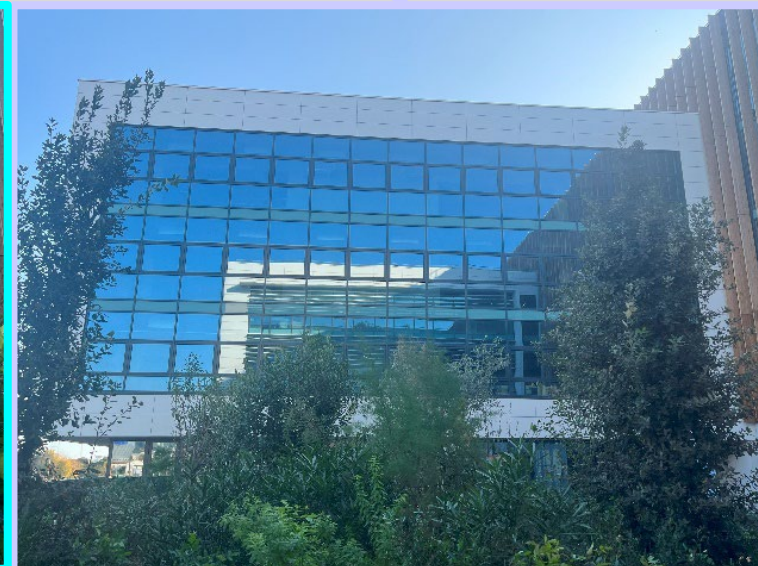
Bureaux Bloc C
