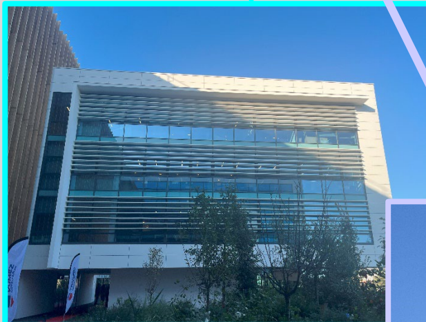
Bureaux Bloc B
