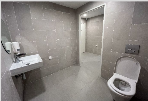
WC avec réservoir isolé, pré-réglé d'usine en 3l/6l
