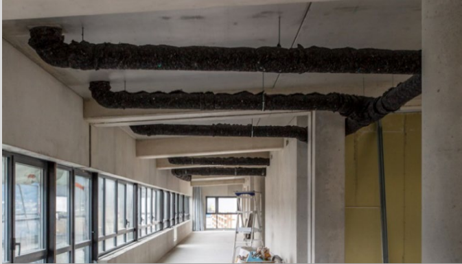
Isolation acoustique réseaux EP avec isolant biosourcé (coton recyclé)!
