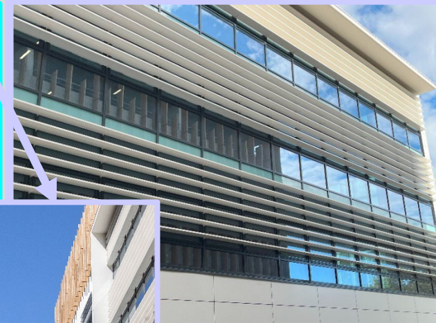
Bureaux Bloc C
