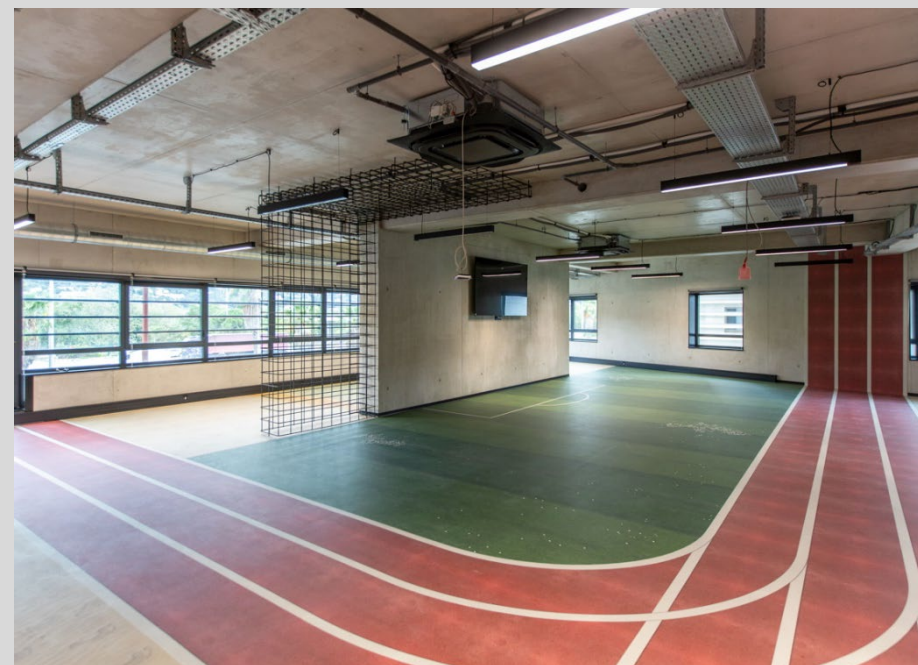
Septembre 2024 Pose du sol de la salle de sport
