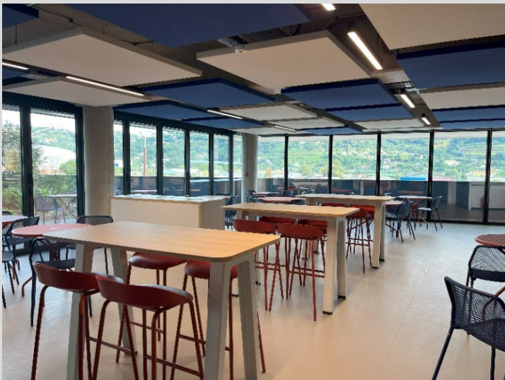
Baffles acoustiques dans salle de restauration
