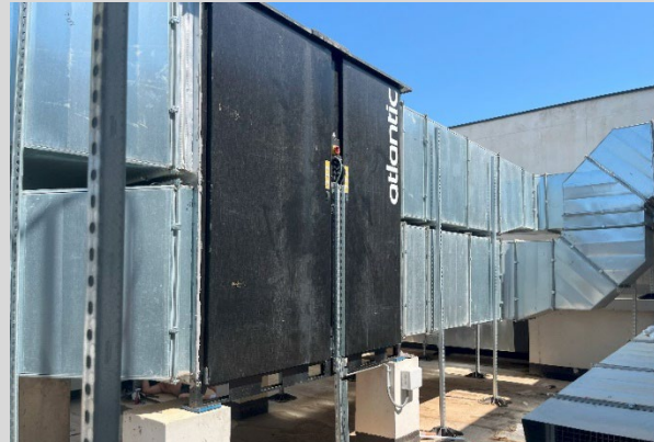
CTA Double flux Bâtiment B
