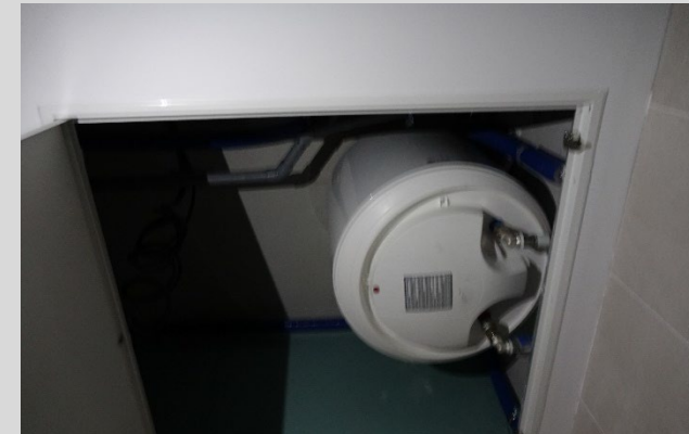
Ballons électriques 50 L /sanitaire
