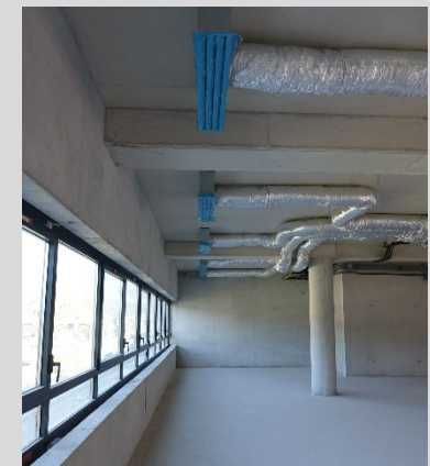
Alignement de diffuseurs à lames
