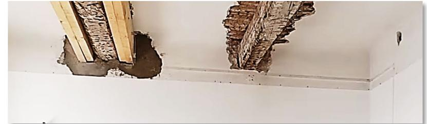
**Renforcement des poutres par moilage (plaques boulonnées en métal ou en bois).**
