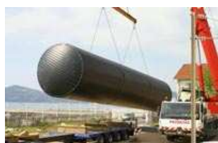
Cuve double-peau d'Aquavalor en PEHD (pour contenances importantes)
