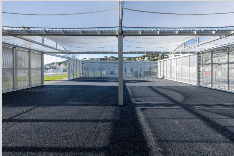
Bâtiment 4 zone technique
