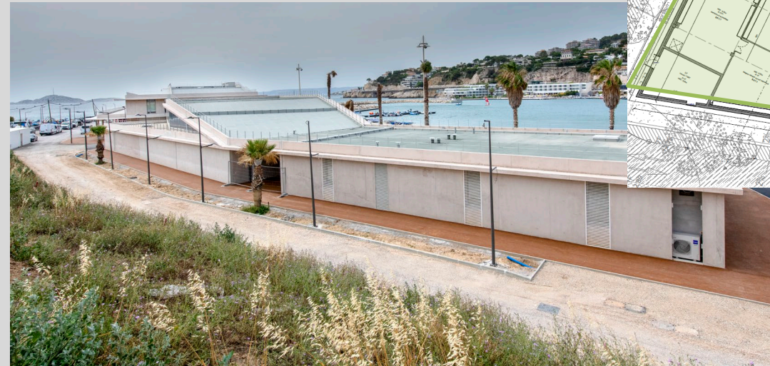
Bâtiment 2 Façade Sud
