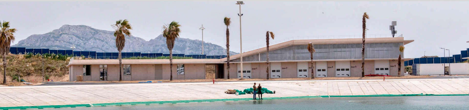
Bâtiment 2 Façade Nord
