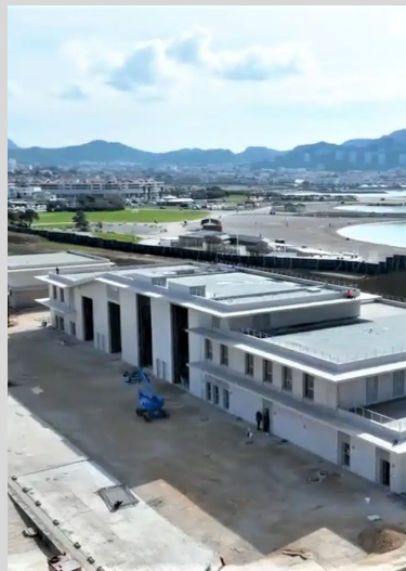
Bâtiment 1 Façade Ouest
