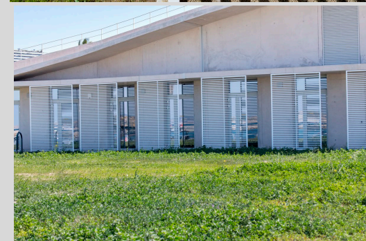
Bâtiment 4 Façade Ouest
