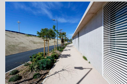
Bâtiment 4 Façade Est
