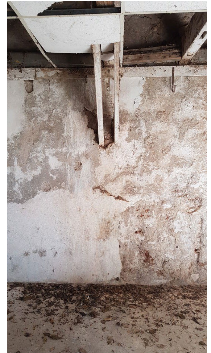
Charpente et enduit mur intérieur
