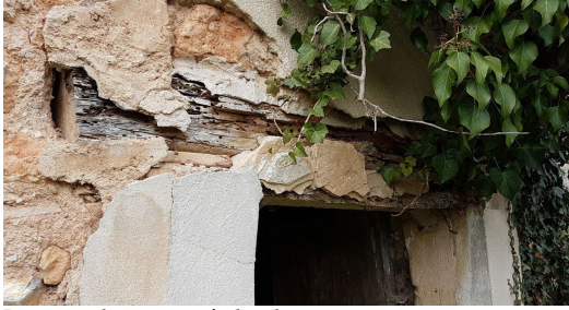
Linteau en bois encastrés dans les maçonneries
