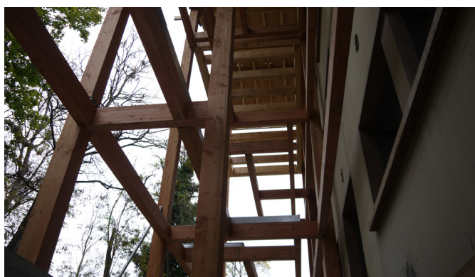
Structure porteuse de la coursive du bâtiment A, intégrant circulations horizontales et verticales
