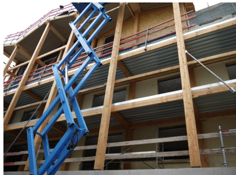
Structure porteuse de la surélévation du bâtiment A, façade sud-ouest (balcons)
