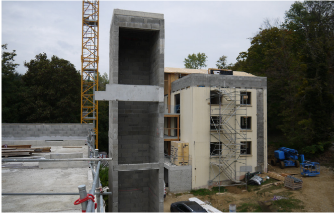
Construction de la cage d'ascenseur du bâtiment B
