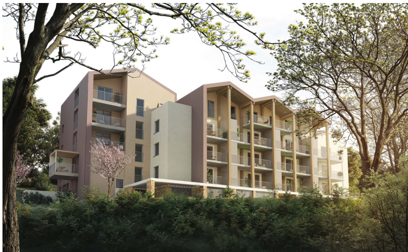
© Rhône Saône Habitat - Vue de la réhabilitation du bâtiment A et ses extensions
