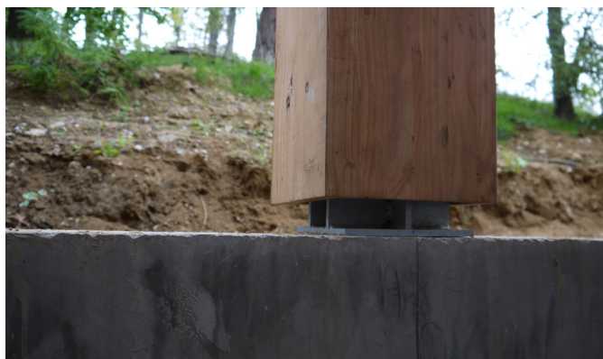
Assemblage métallique Poteau bois – Muret béton
