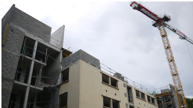
Bâtiment B : existant conservé + extension en blocs béton aggloméré (à gauche sur la photo)
