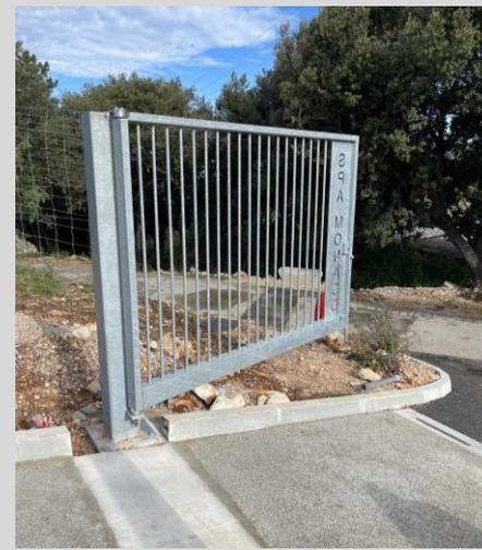
Espèces végétales locales, revêtement extérieur drainant pour laisser l'infiltration des eaux à la parcelle/ stockage d'eau de pluie, clôtures périphériques du site avec mailles 17cm \*10,2cm, conformes aux prescriptions de l'écologie pour permettre la perméabilité du site aux espèces endémiques.
