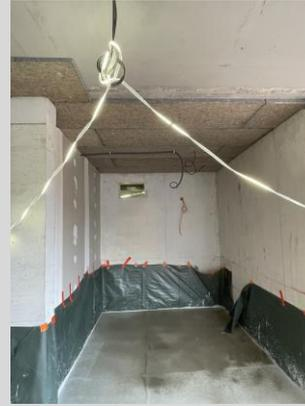
Mise en œuvre et protection des chapes et mur en béton brut dans la zone bureaux (périmètre d'évaluation BDM)
