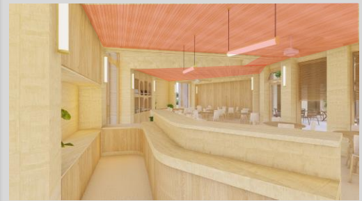
Absorbant bois en plafond
