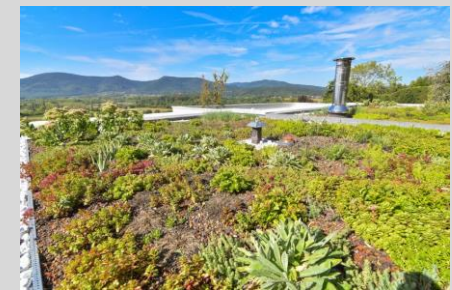
Toiture végétale garrigue H 10cm à 60cm sédums vivaces bulbeuses vivaces herbacées petits ligneux
