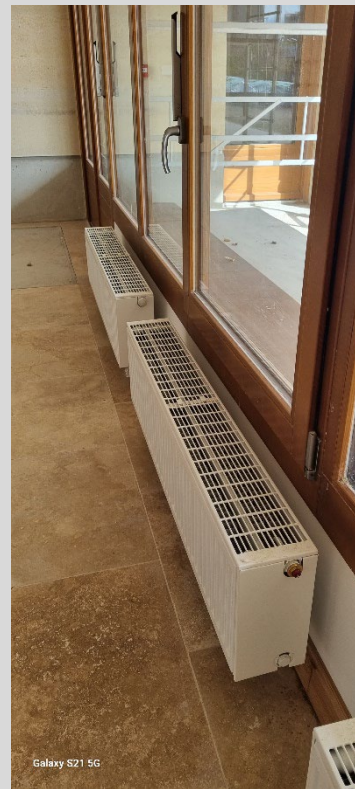
Des radiateurs basse température dans tous les locaux du Relais (variation temporelle 0,2°C)
