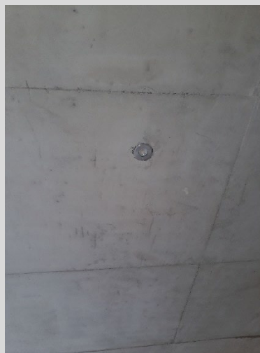
Eclairage extérieur des galeries couvertes
