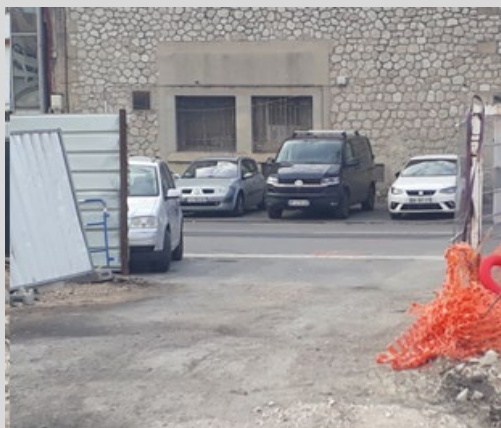
Maintien en propreté de l'accès au chantier
