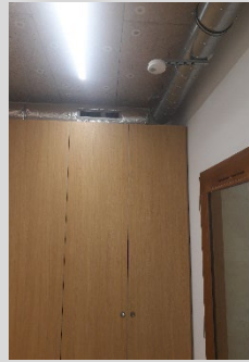
Gaines acier d'extraction d'air et détecteur de présence - salle de réunion
