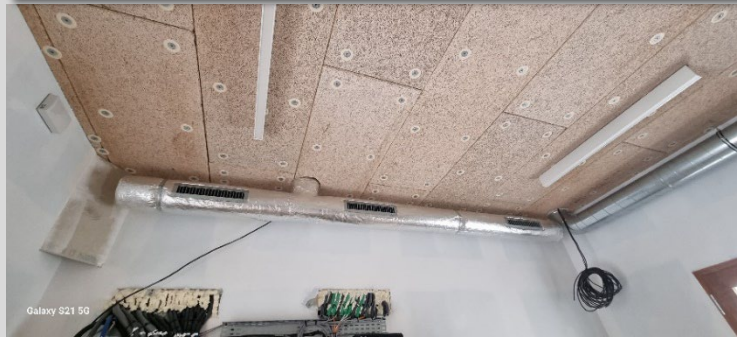
Gaine acier d'introduction d'air neuf - salle de réunion
