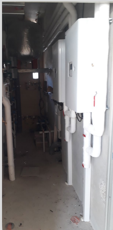
Armoire de production thermique et couloir technique accessibles depuis l'extérieur
