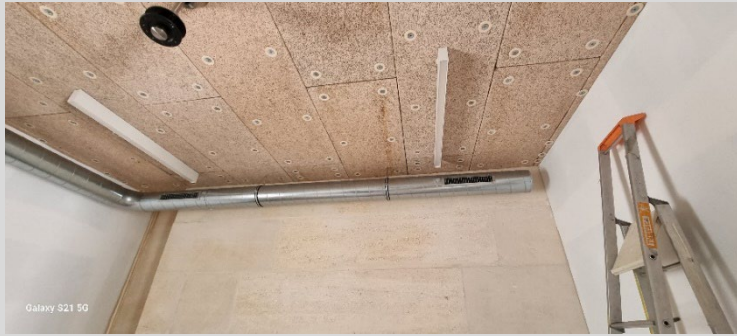
Gaines acier d'extraction d'air et détecteur de présence - salle de réunion
