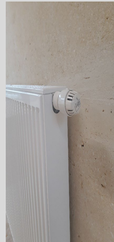
Des radiateurs basse température dans tous les locaux du Relais (variation temporelle 0,2°C)
