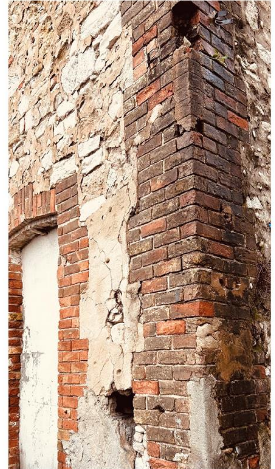
Ateliers Avenue Cap Pinède Marseille 13015
