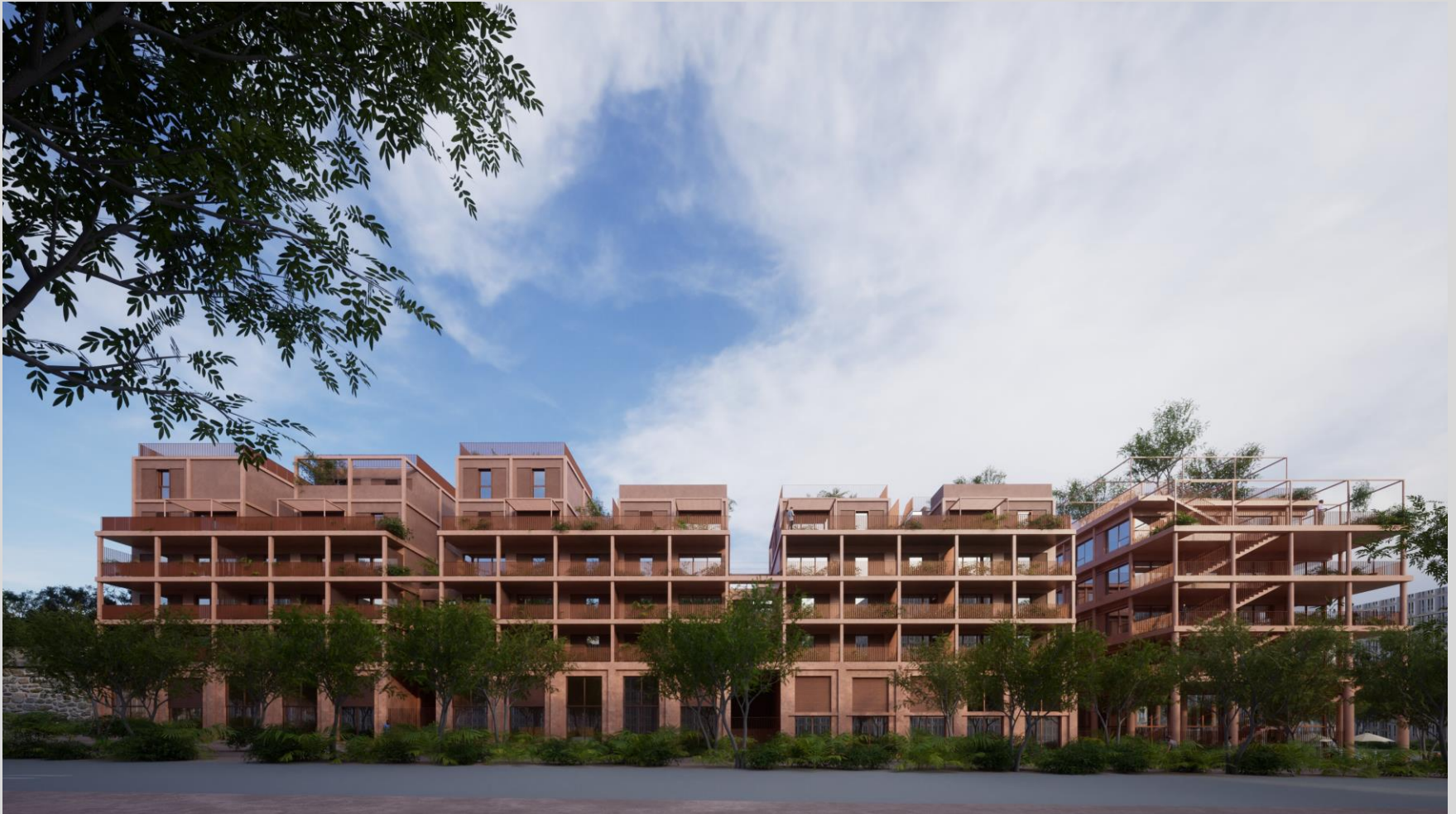
Vue depuis avenue Cap Pinède
