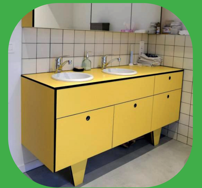
Lavabos de réemploi encastrés sur un meuble réalisé sur mesure, Logements collectifs à Bruxelles, Rotor avec Twyce architecte, réalisation entreprise Treesign, 2022
