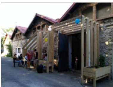
ASF > BIDONVILLE DES ACIERIES Chantier participatif pour la construction d'un lieu commun
