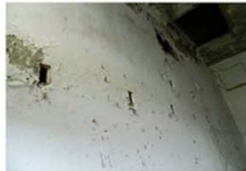
Traces de réservations de supports de planchers techniques
