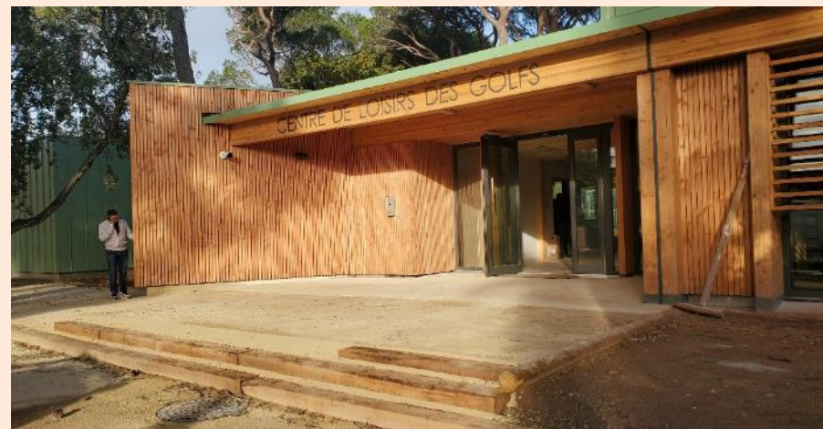
Parvis en béton drainant avec emmarchement en tasseaux de bois
