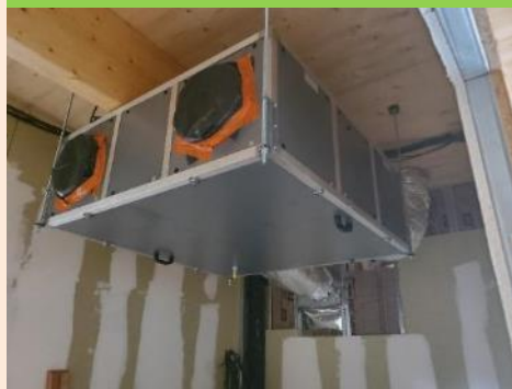
Conduits de ventilation protégés
