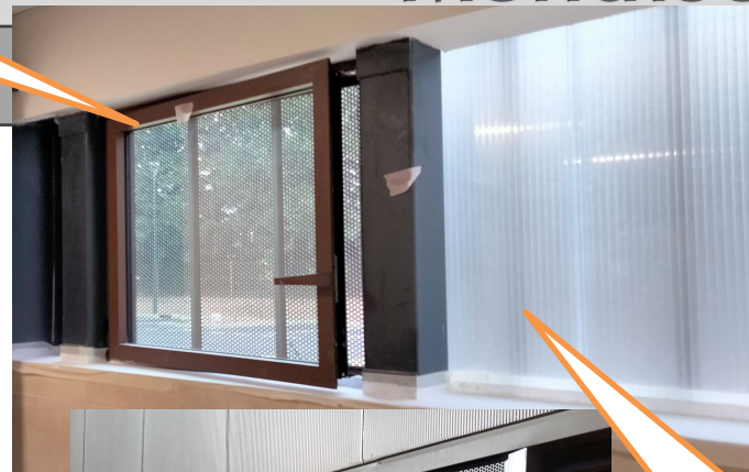
Locaux lumineux : translucides dans l'usine
