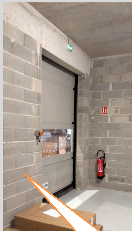
Murs séparatifs coupe feu laissés bruts dans l'usine
