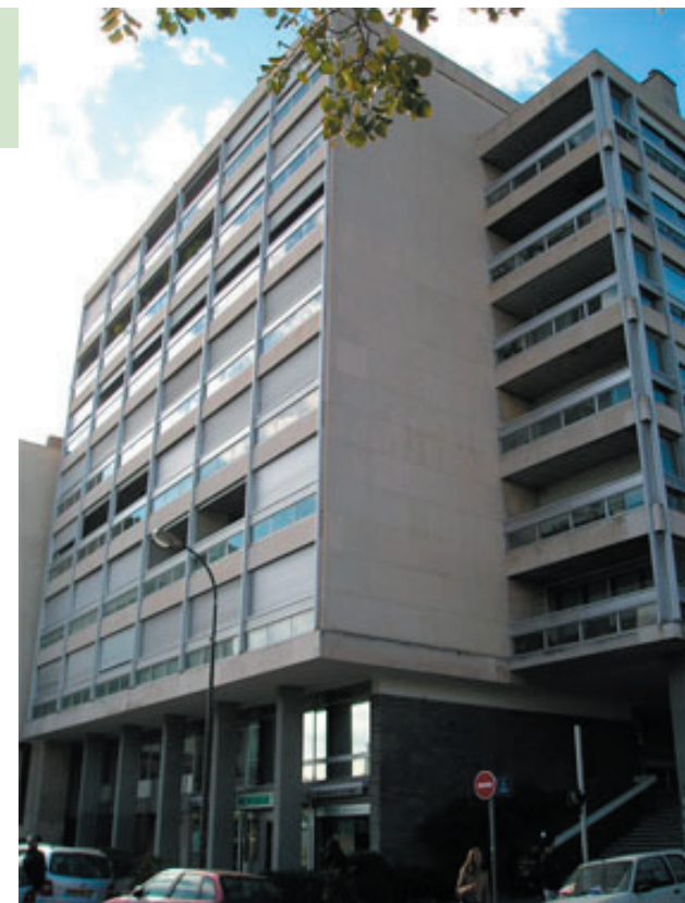
Façade sur Le Prado
