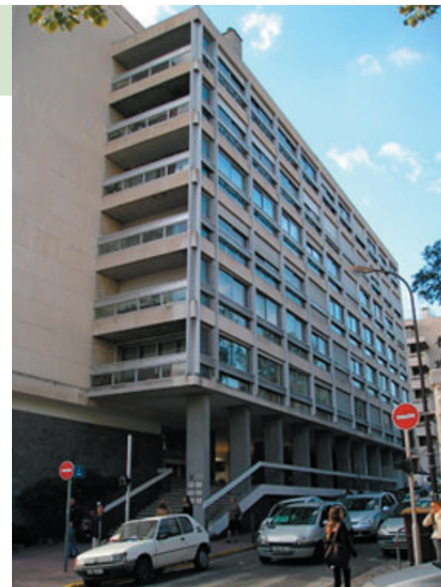
Façade sur rue Daumier
