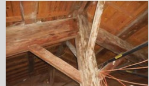
Charpente bois bâtiment A
