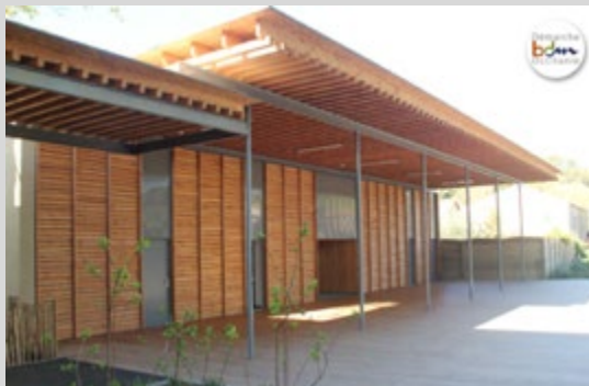
Groupe scolaire de Courbessac - Nîmes -BDM Argent BE Structure : GAUJARD TECHNOLOGIE BE VRD : ELLIPSE *Architecte mandataire : Atelier GA
