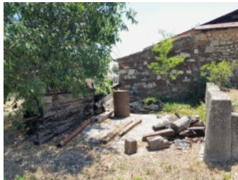
Ancienne zone de stockage de charbon
