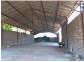
Hangar au Nord
