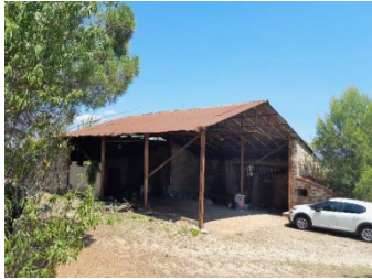
Hangar au Sud
