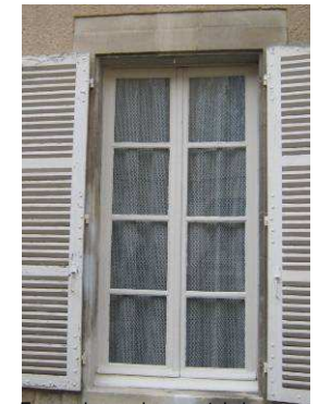
En cas de remplacement de la fenêtre, les nouvelles menuiseries devront reprendre les mêmes dimensions que celles d'origine
