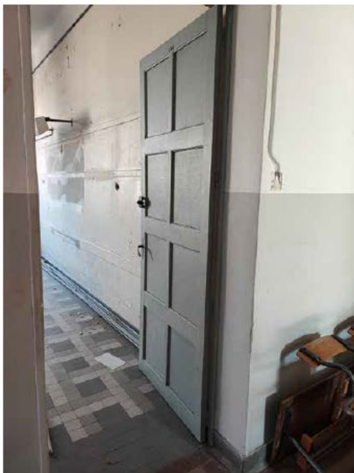
Réemploi des portes existantes en bois, et d'une partie des faux-plafonds pour les pièces techniques
