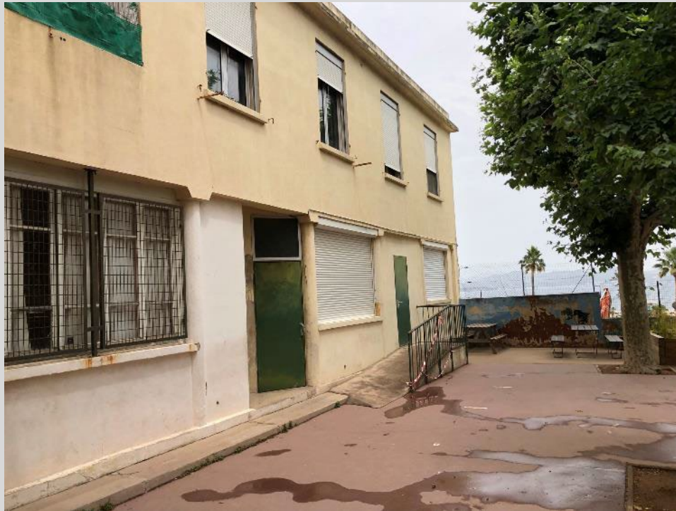
Annexe existante démolie
