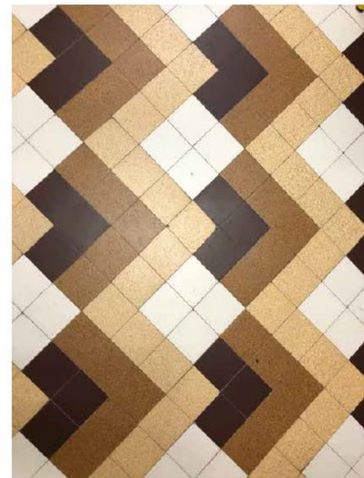
Conservation des sols existants au rez-de-chaussée et au R+1
