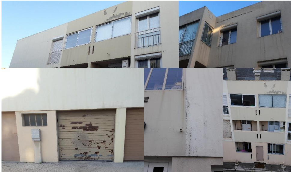
Résidence Les Cyprès (AVANT les travaux)
