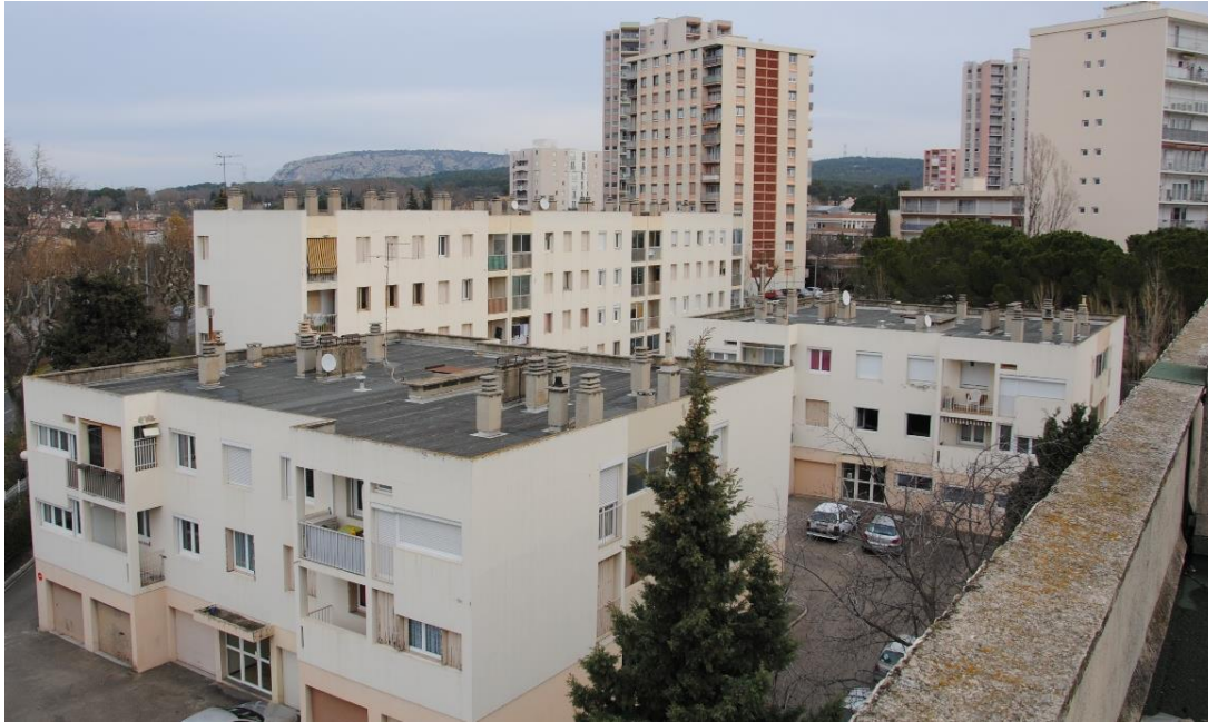
Résidence Les Cyprès (AVANT les travaux) dans le quartier des Canourgues
