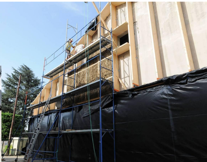
La pose de la paille
