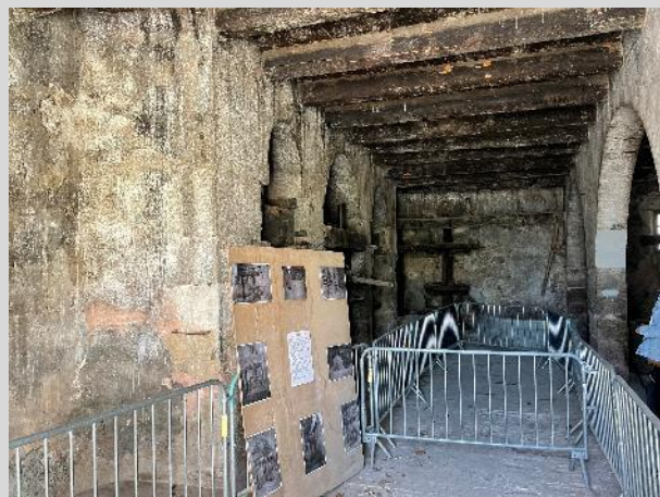
Les Presses du moulin sont en fonte datant du XIXème siècle.
