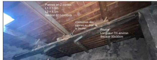
Figure 8 Sections/longueur pannes et poutre inclinées
