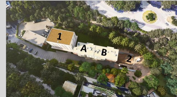
2_Déconstruction de la cage C
