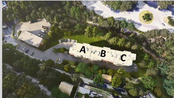
0_Etat initial - Travaux préparatoires
