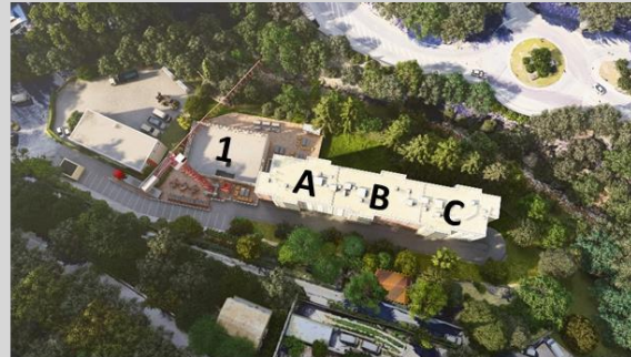
1_Construction du Bâtiment 1
