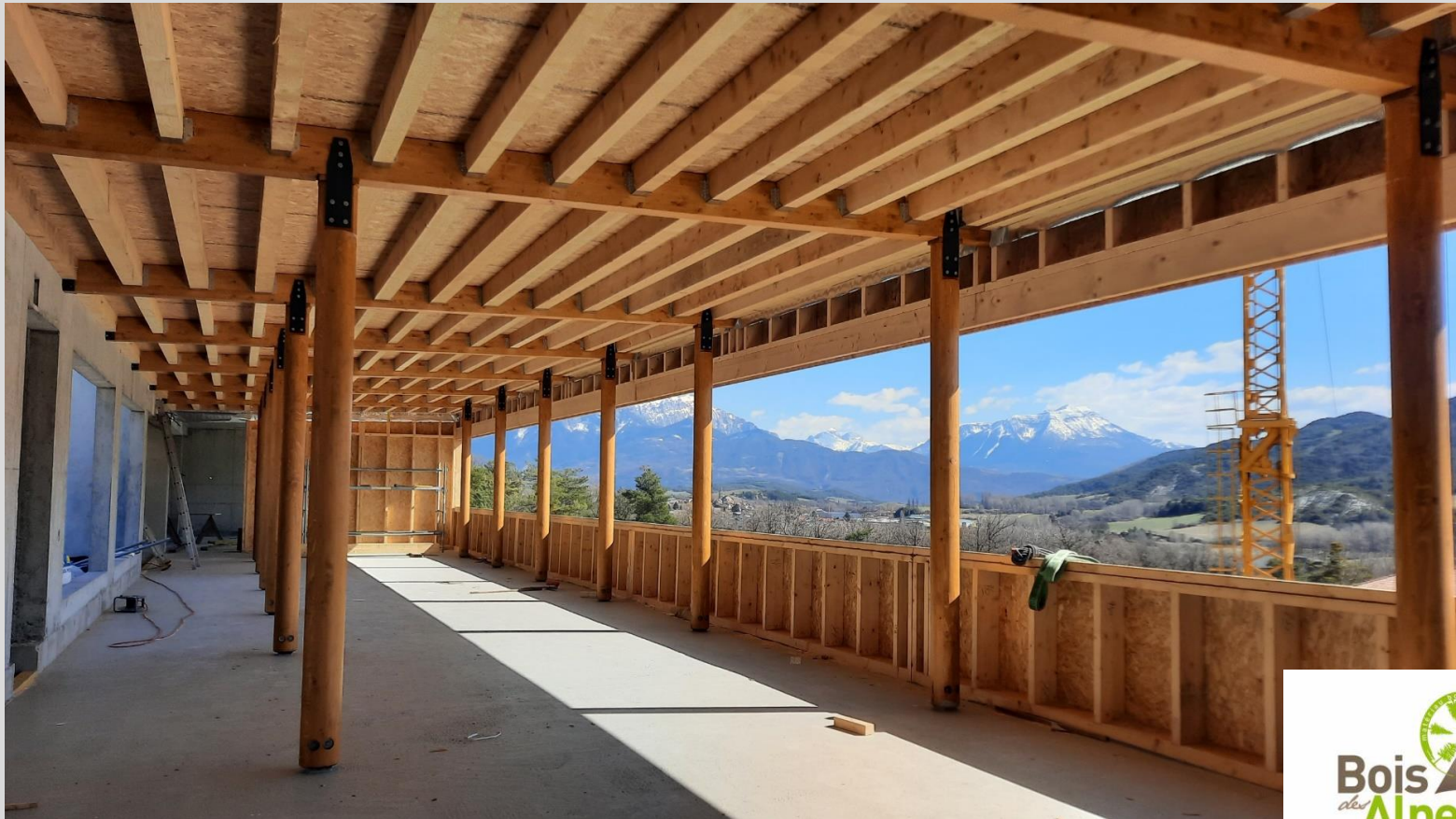
Façade, structure et plancher bois
