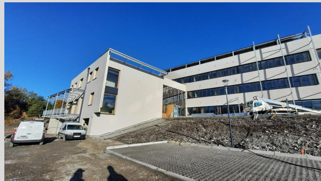
Façades enduites – aménagements extérieurs
