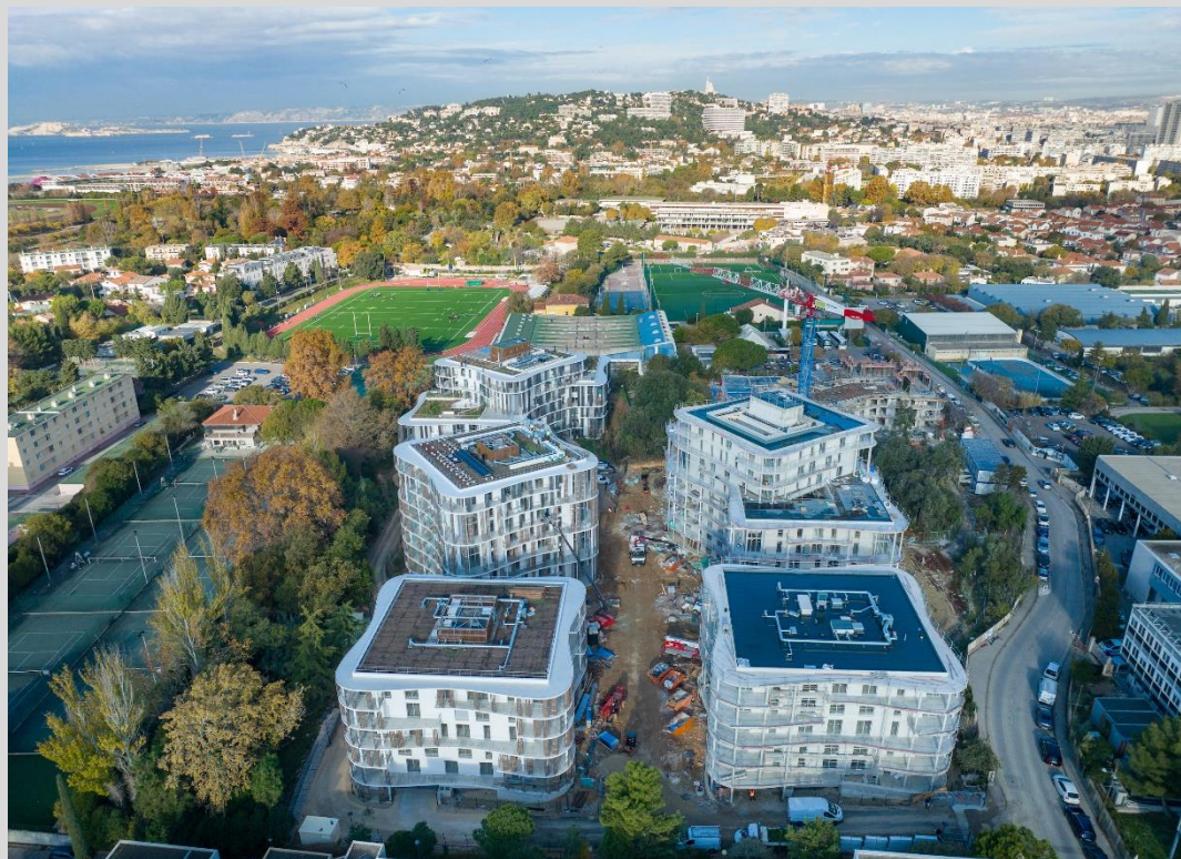
Projet en cours de construction
