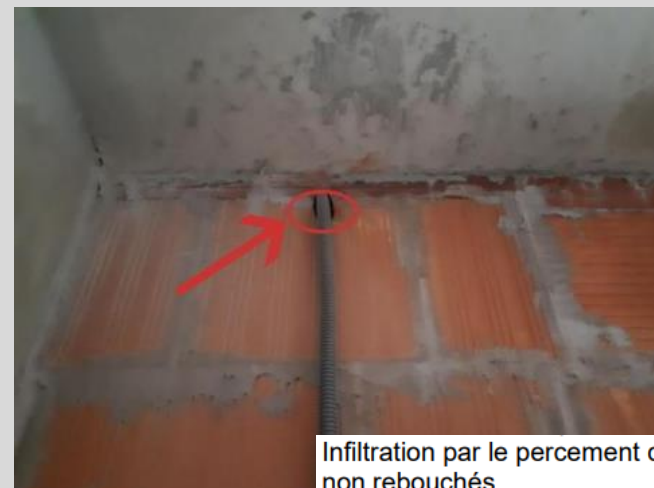
Forte infiltration au niveau des gaines, trémie non rebouchée
