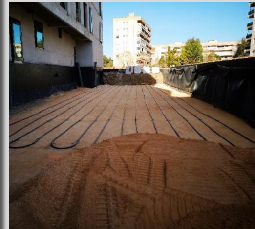
Réalisation du puit climatique
