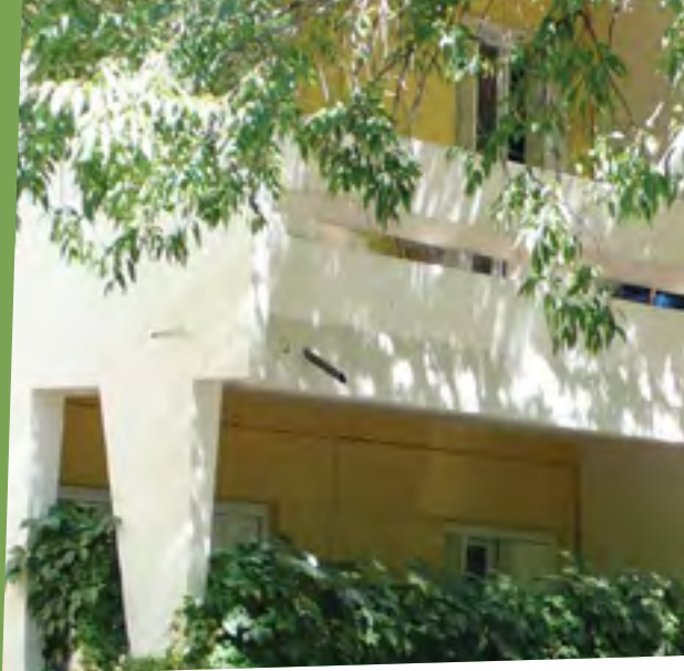
Ombrage procuré par une végétation proche des bâtiments © EnvirobatBDM
