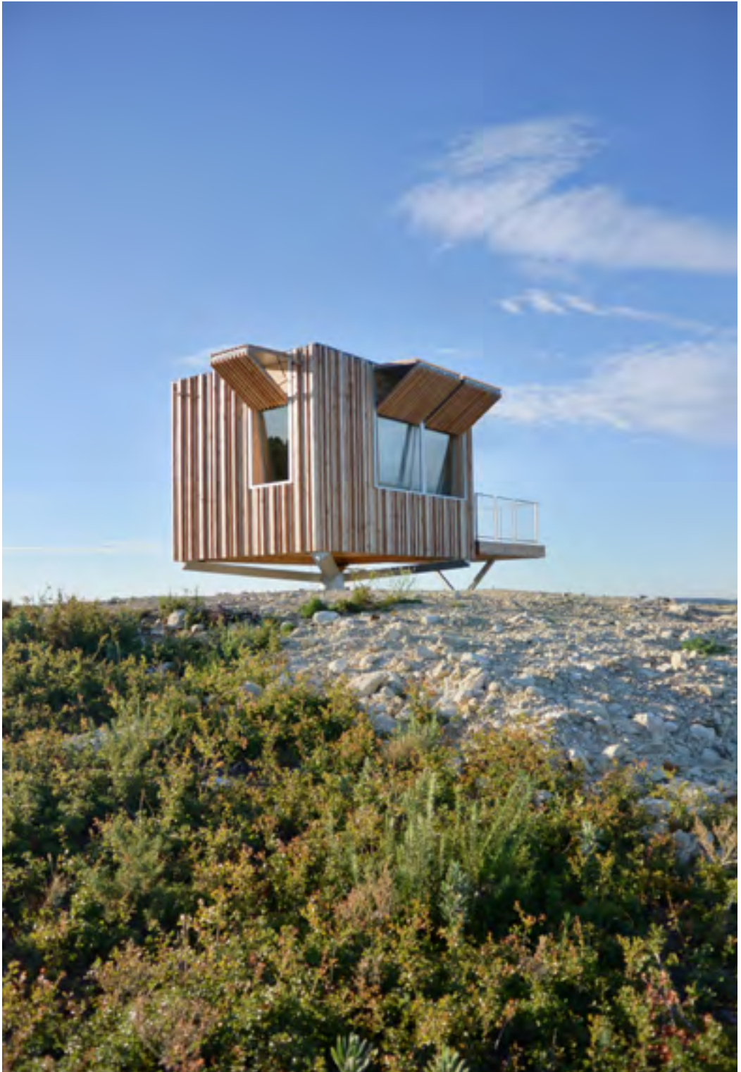
Volets pliants papillons ouverts vers le haut qui forment une casquette, vigie de détection des feux - Forêt de Figuerolles à Martigues (13) © oh!som architectes
