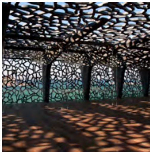
Mucem : résille en béton, faisant office de protection solaire sur les façades sud-ouest. © Architectes : Rudy Ricciotti et Roland Carta / Mucem / Photos : Lisa Ricciotti
