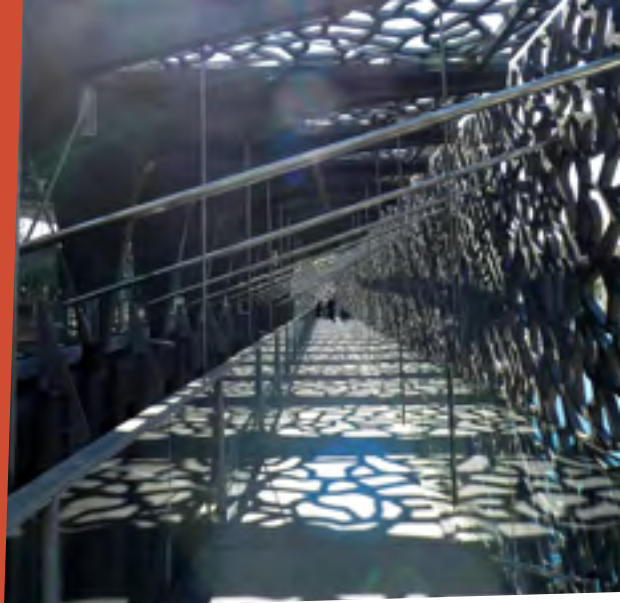
Mucem : résille en béton, faisant office de protection solaire. © Architectes Rudy Ricciotti et Roland Carta / Mucem / Photos : Lisa Ricciotti
