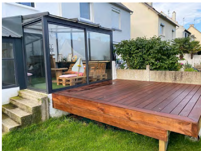
APRÈS : la terrasse, réalisée après notre passage (photo propriétaire)
