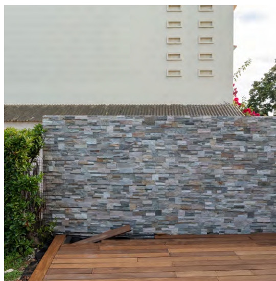
Construction d'une terrasse maison T6
