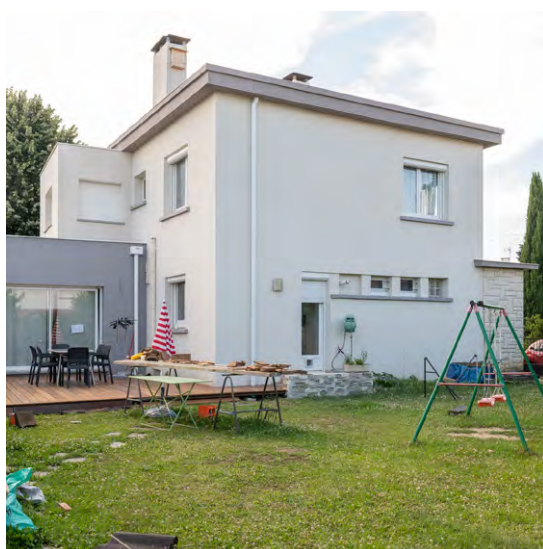
Construction d'une terrasse maison T6
