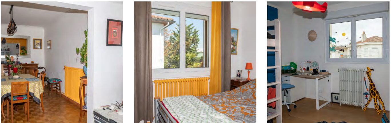
Radiateurs conservés et restaurés (T1 et T2)
