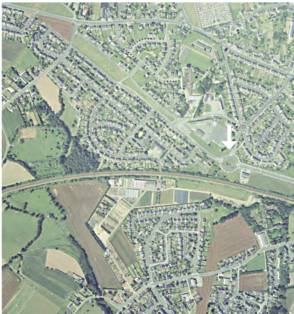
En 1997, le maillage lotissements/terres agricoles est encore visible. Sous la flèche, le rond-point qui s'est substitué aux ruines de Château Bily (source IGN)
