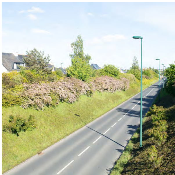
Le boulevard Robert Schumann, créé avec un profond décaissement n'est pas accessible aux piétons. La végétalisation soignée des talus y est remarquable. Saint-Brieuc
