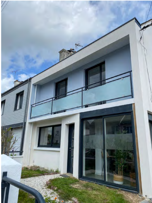
Maison Logéco rénovée (Photo propriétaire SB1)
