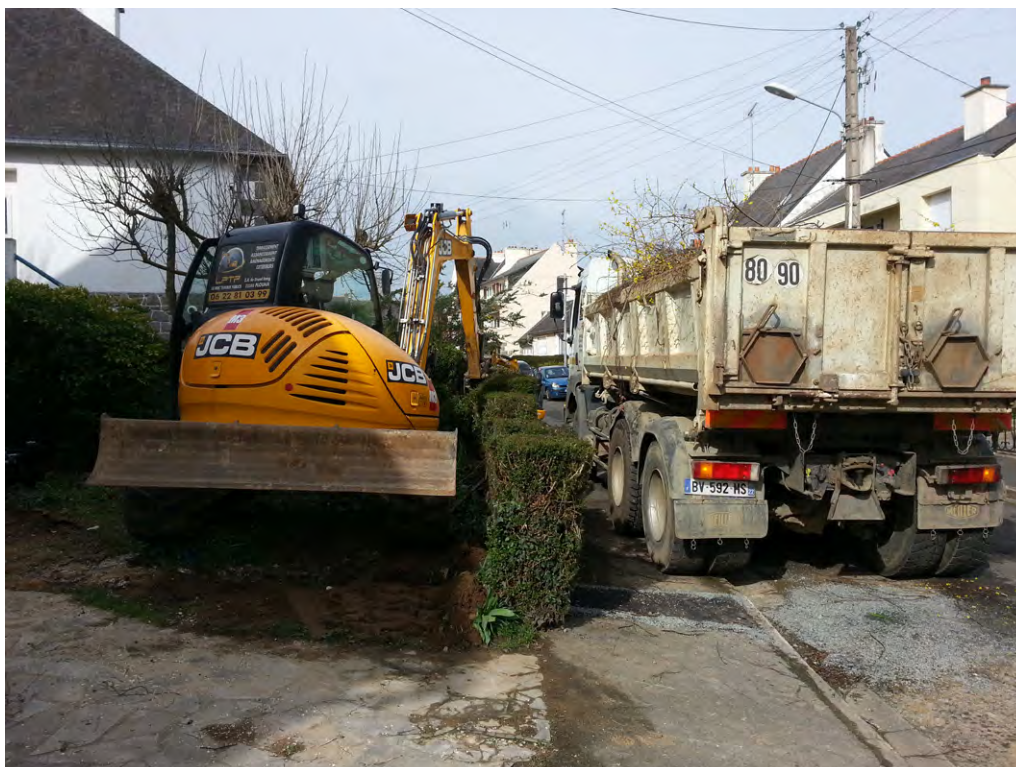
Le chantier d'arrachage chez SB4 (photo propriétaire)
