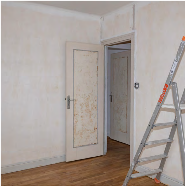
Un parquet conservé et éclairci par ponçage (SB5)
