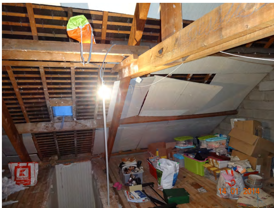
État initial des combles chez SB2 (photo propriétaire)
