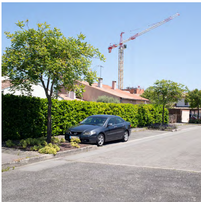
Une grue sur le chantier du futur quartier situé à proximité de la station de métro Airbus-Ramassiers
