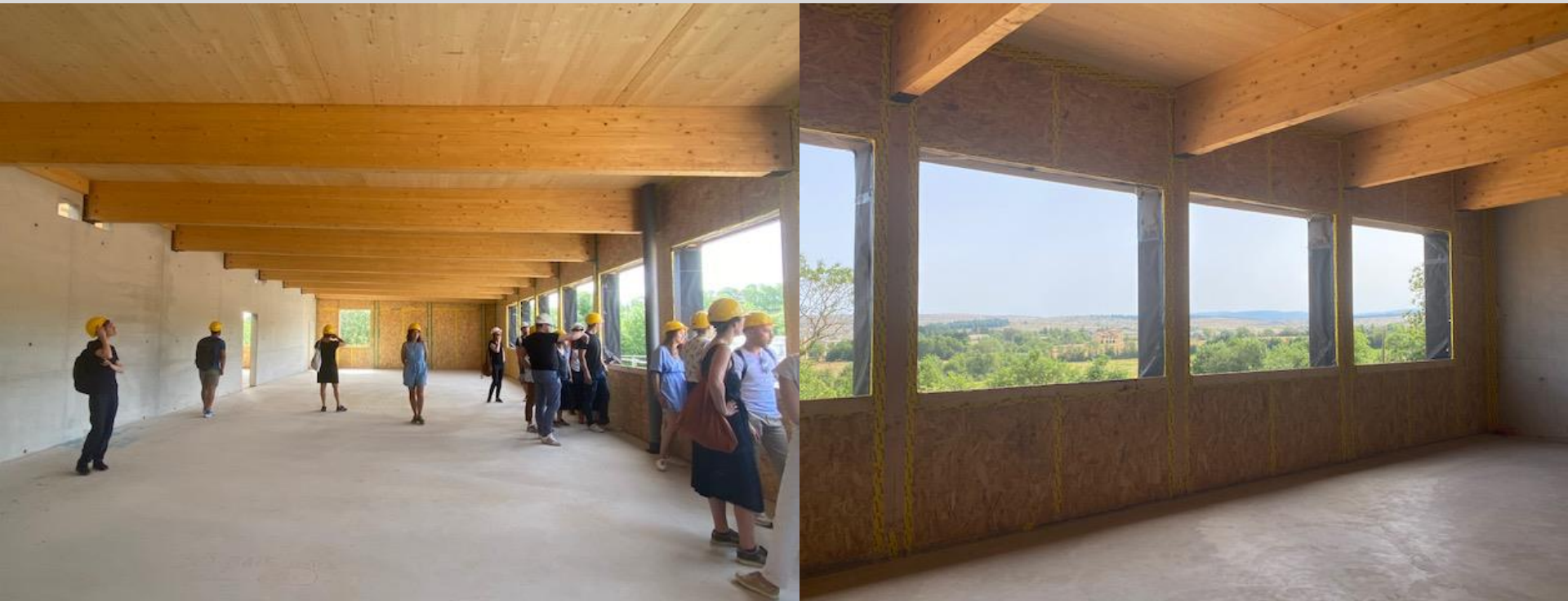
Chantier du Collège de la Cavalerie - BPA
