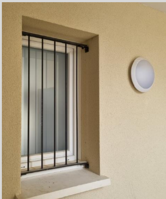
Grilles sur menuiseries pour pouvoir ventiler en sécurité
