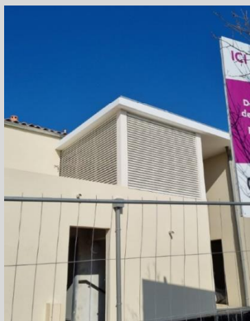
Optimisation par calcul de l'emplacement des brises soleil verticaux sur la façade Ouest
