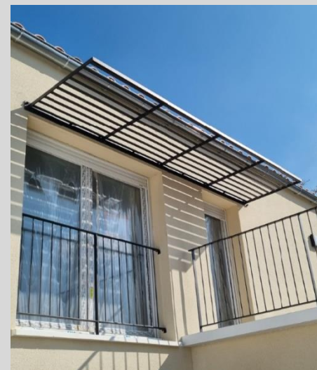
Optimisation par calcul des lames des brises soleil horizontaux sur façade Sud
