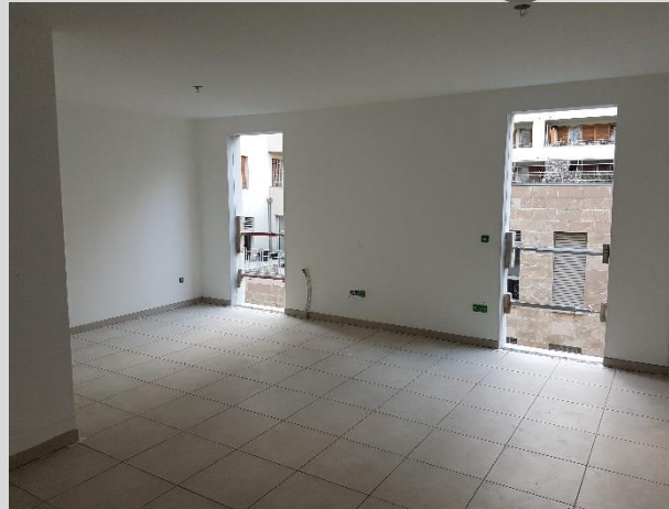
Pose du carrelage et mise en peintures
