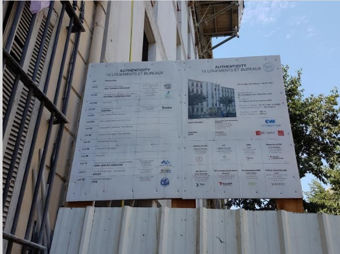
Panneau de chantier
