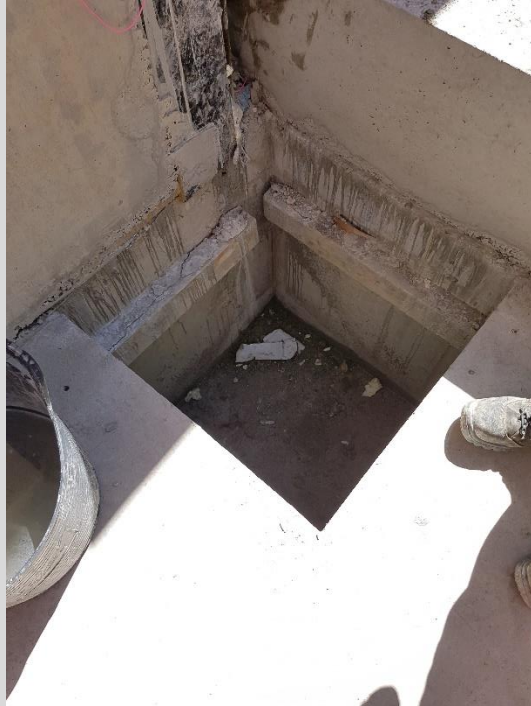
Bassin de rétention
