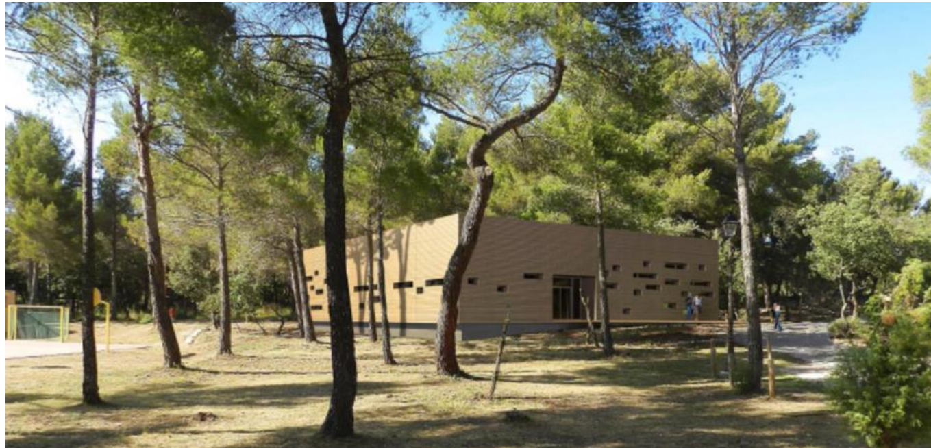
Salle des sports Saint Marc Jaumegarde, Architectes : Battesti et associés
