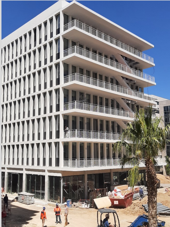
Façade sud (AB)
