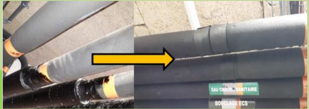
Reprise des isolations de réseaux + identification
