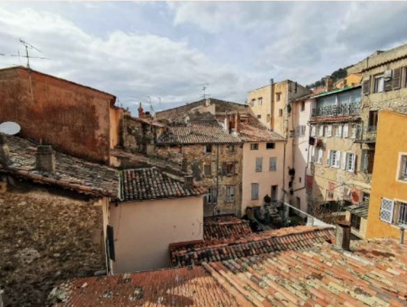
Façades sur cour
