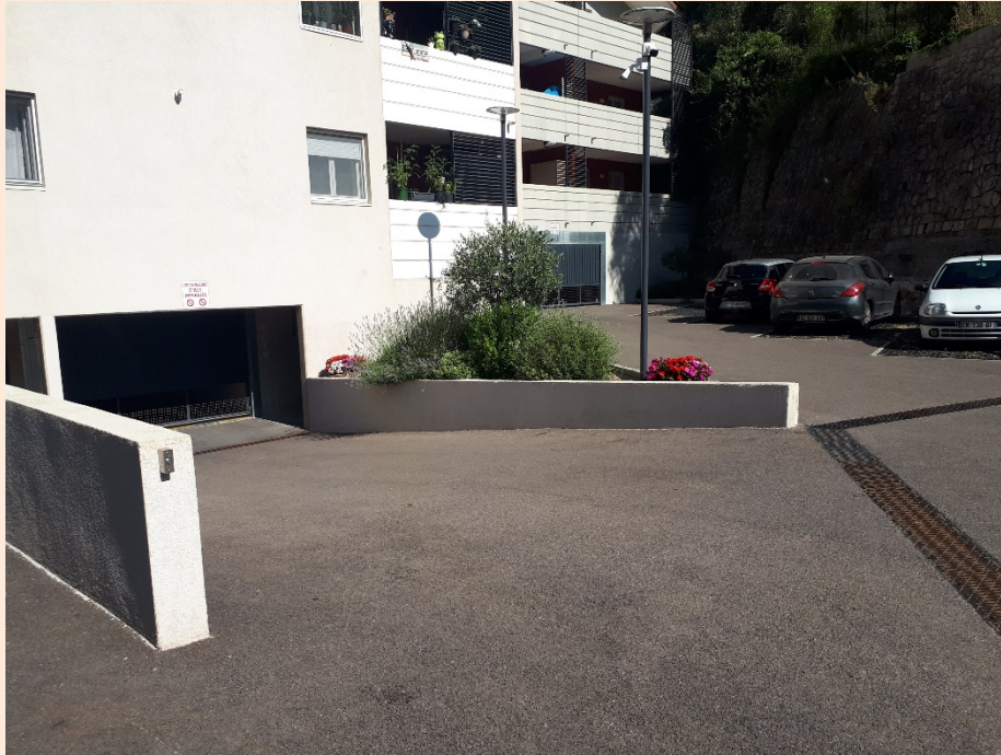
Est : descente parking
