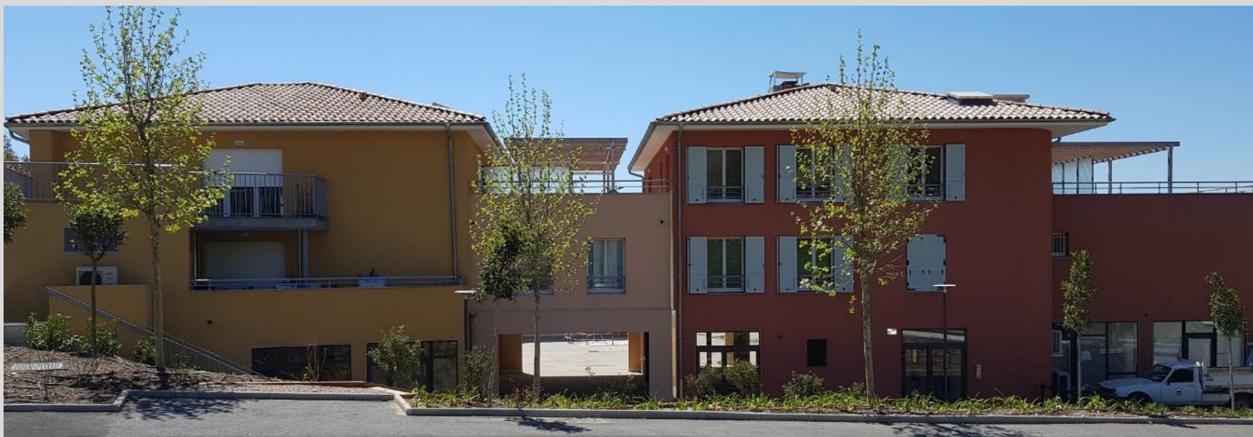
Collectif Façade Nord
