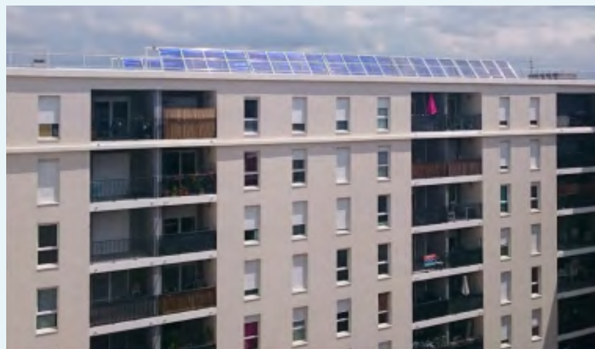
Copropriété Ilot 18 - Marseille. © ECOGIA
