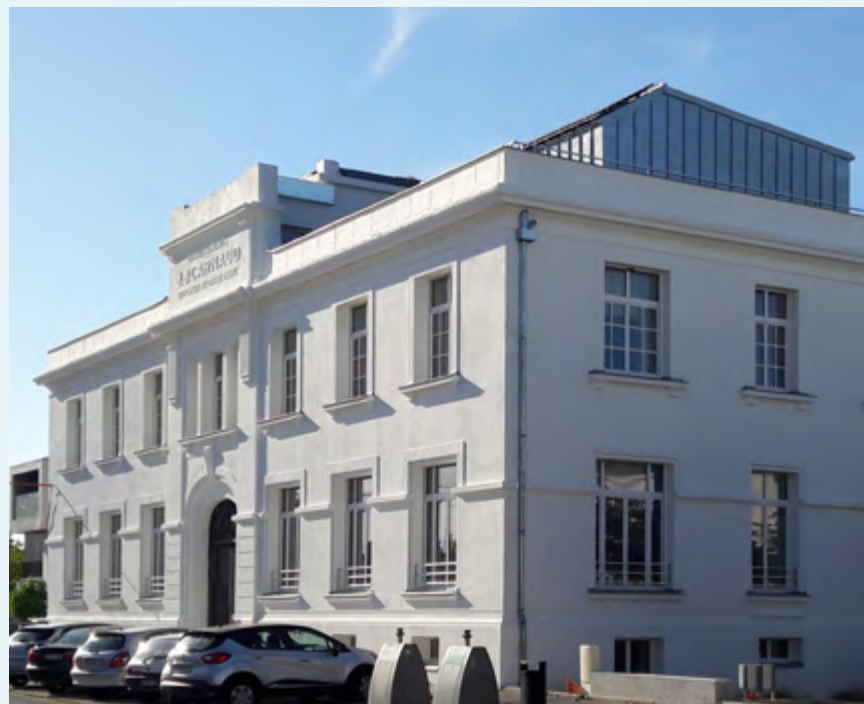
Bâtiment la Marseillaise - Nantes. © Vincent Braire.
