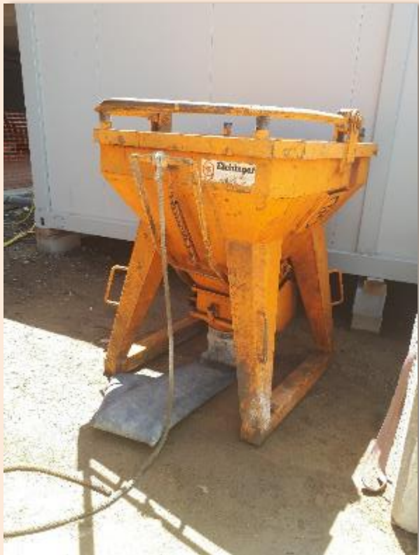
Décantation eaux de lavage béton
