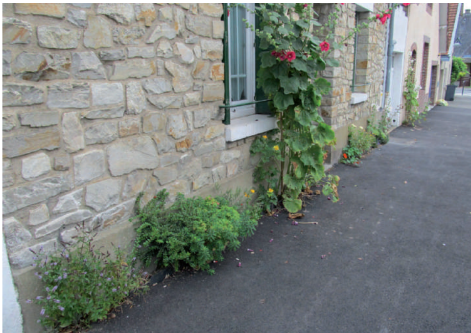
Végétalisation d'un pied de façade sur trottoir
