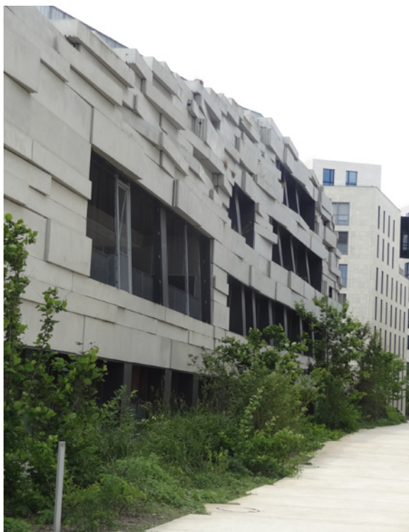
ÉcoQuartier Le Trapèze, Boulogne-Billancourt
