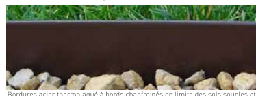
Bordures acier thermolaqué à bords chanfreinés en limite des sols souples et des copeaux de bois (couleur à définir)
