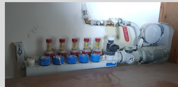
Vannes de régulation installées dans les classes
