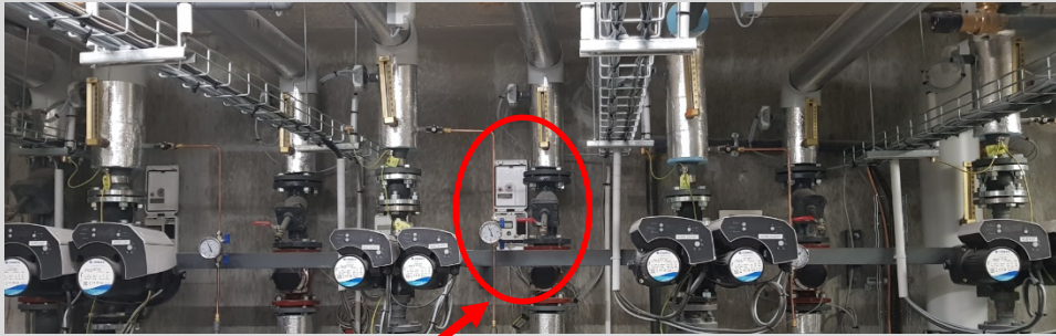
Comptage kWh sur départs eau chaude chauffage dans sous sol
