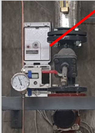
Comptage kWh sur départs eau chaude chauffage dans sous sol
