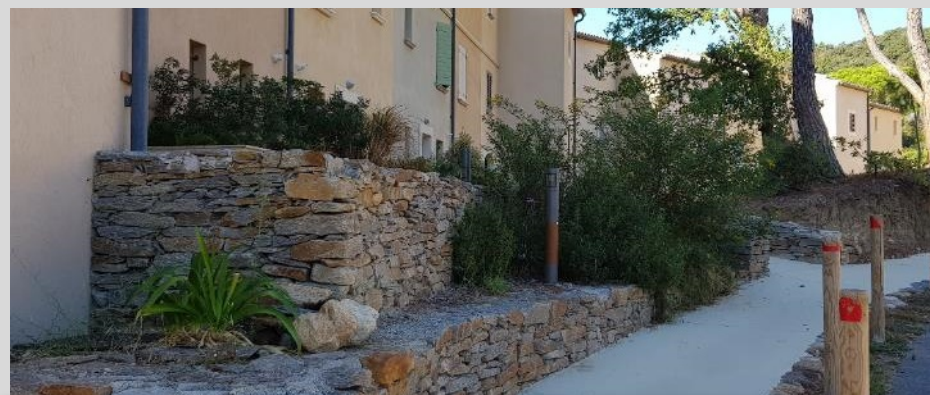
Murets en pierres de carrière de Bormes les Mimosas
