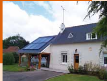
> Capteurs thermiques intégrés en toiture secondaire (Chauffage)
