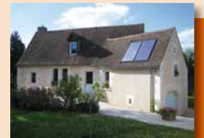
> Capteurs intégrés en toiture (CESI)
