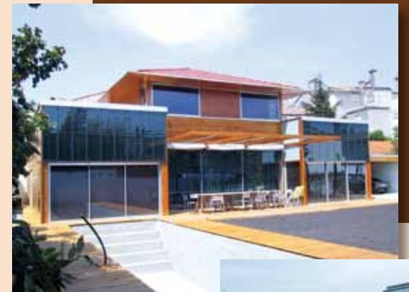
> Capteurs thermiques en façade (Chauffage)
