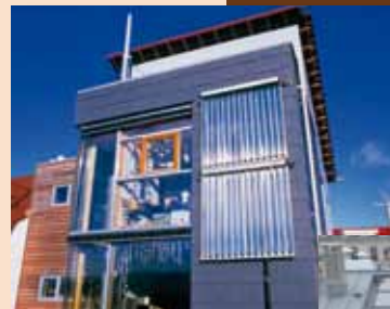
> Capteurs sous vide en façade
