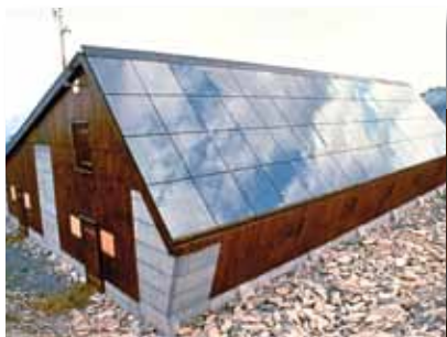
> Toiture complète en photovoltaïque
