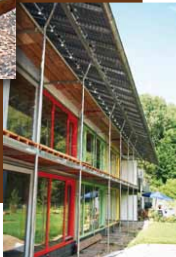
> Photovoltaïque en toiture avec auvent
