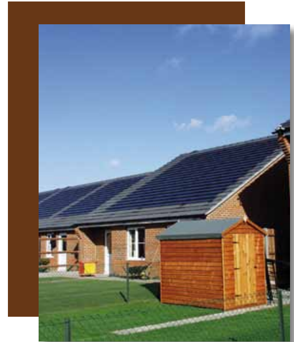
> Intégration photovoltaïque en toiture
