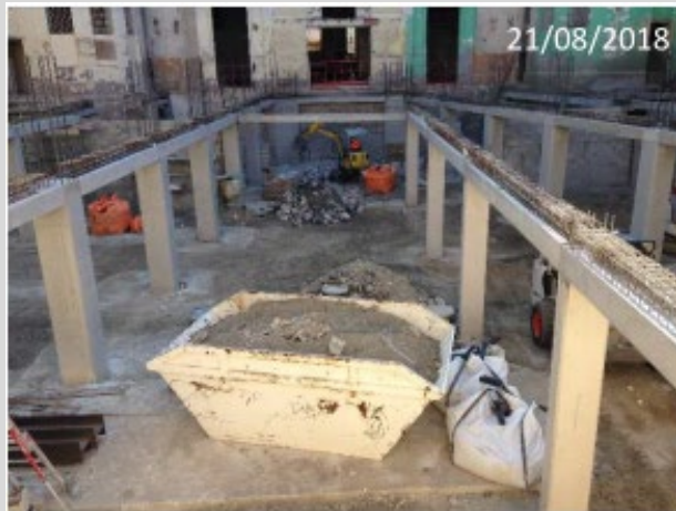
Réalisation des poutres du plancher haut sous-sol au niveau de la zone centrale du bâtiment Mise en place du tout-venant sous dallage
