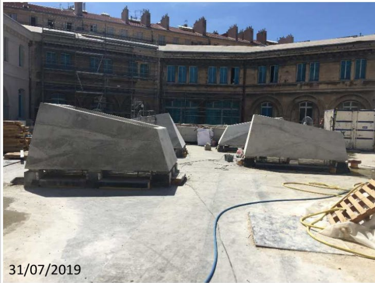
Collage des coques de la terrasse accessible en béton brut
