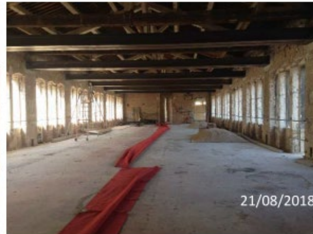
Pose des poutres métalliques au PH R+2
