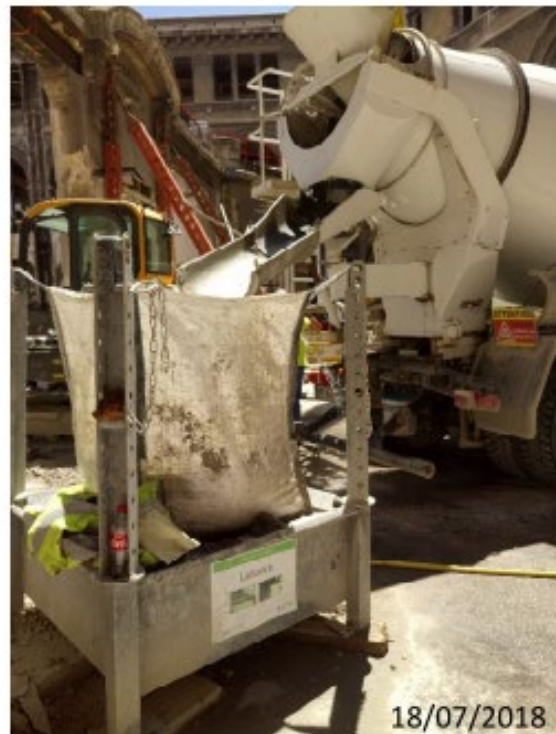
Lavage de la goulotte de la toupie de béton- Bac de rétention de laitances de béton
