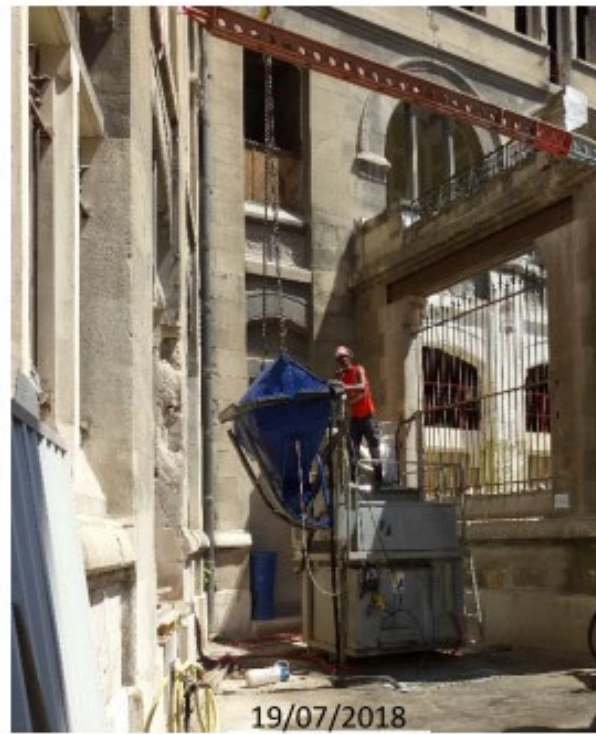
Lavage de la benne de coulage de béton - BETONET GC 2000
