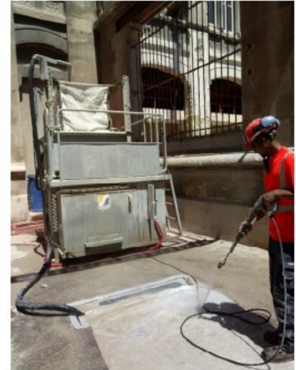
Lavage de la bâche mise en dessous du camion toupie lors du remplissage de la benne (Elle sert à récupérer les fuites de béton au sol)
