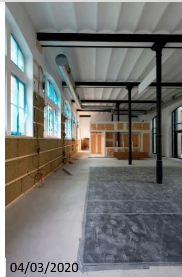
Vue sur l'avancement des travaux dans le RIE
