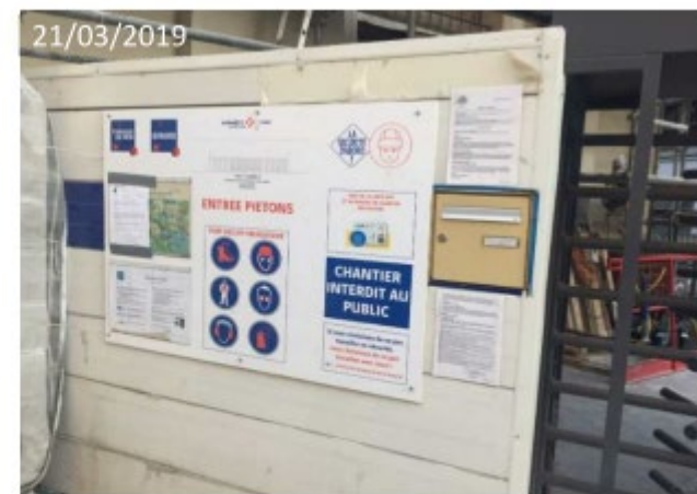
Panneau d'affichage situé à l'entrée du chantier
