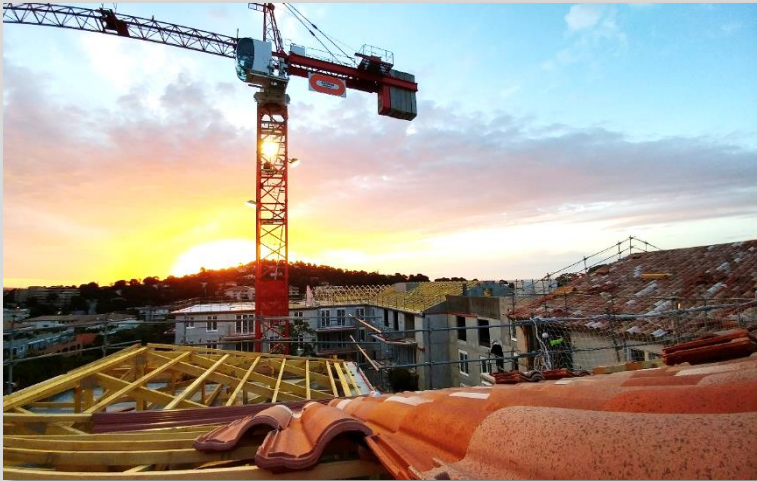
Charpente en bois
